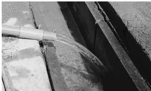
地下水を掘り当てた瞬間 揚水状況(毎分40リットル)写真提供:(株)日さく
