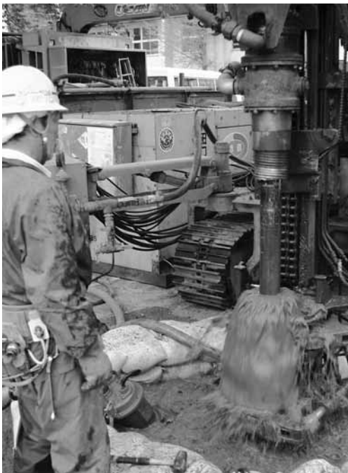
地下水を掘り当てた瞬間 揚水状況(毎分40リットル)写真提供:(株)日さく
